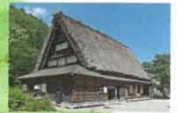
中野長治郎家(県重文) 中野義盛家の分家で、同じく加須良集落から移築したもの。下屋根がこけら葺き(一部厚板葺き)が特徴。農耕具も展示しています。
